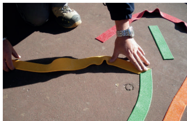
Bend & Shape*, simple à manipuler, rapide à appliquer - vous avez juste besoin d'un balai et d'un chalumeau
