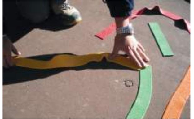
Bend & Shape(\*), simple à manipuler, rapide à appliquer - vous avez juste besoin d'un balai et d'un chalumeau
